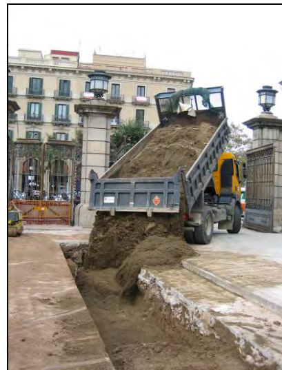
FOTO 12. Aportació de material per tal de reblir el sondeig A
