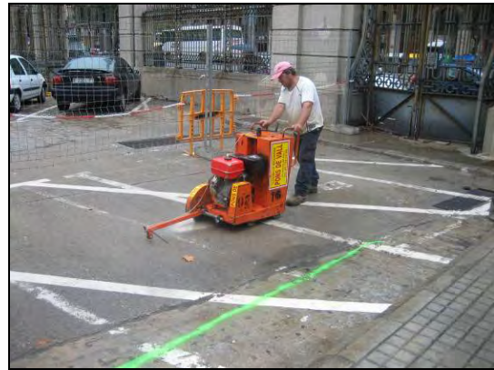
FOTO 2. Treballs destinats a tallar el paviment al sondeig o rasa A
