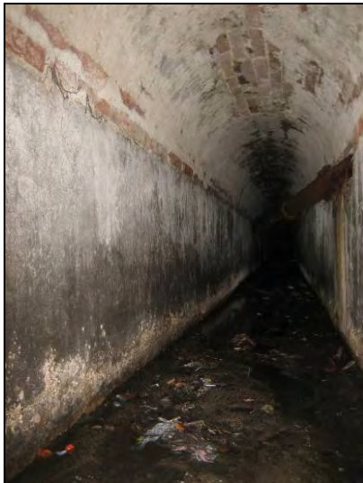
FOTO 19. Vista de l'interior del col·lector localitzat durant la intervenció
