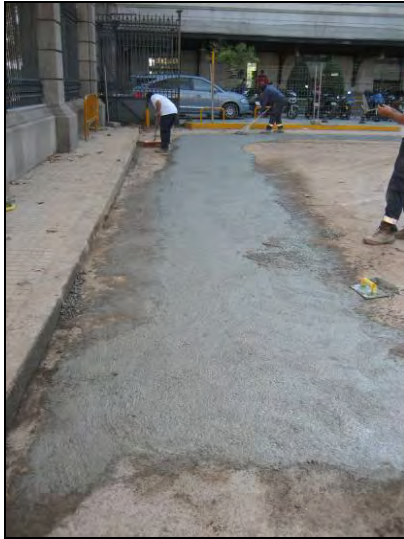
FOTO 33. Zona afectada pels sondejors B2 i C i un cop repavimentada
