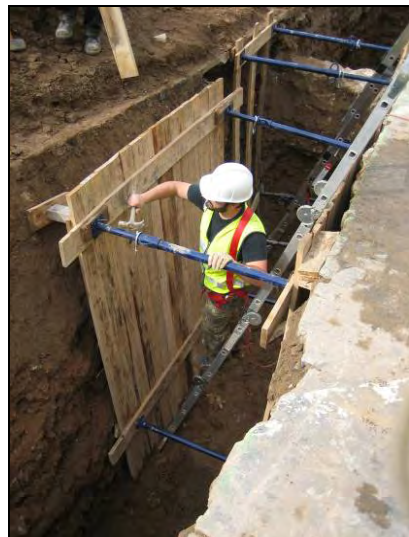
FOTO 8. Feines d'apuntament destinades a documentar l'extrem SE de l'estructura UE 106
