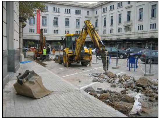
FOTO 14. Màquina retroexcavadora picant el paviment per tal d'efectuar el sondeig B1
