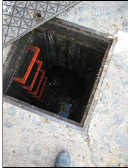
FOTO 18. Un dels accessos al col·lector localitzat durant la intervenció
