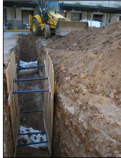
FOTO 30. Protecció / senyalització de les estructures del sondeig C abans de cobrir-les
