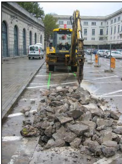
FOTO 3. Màquina retroexcavadora picant el paviment al sondeig A
