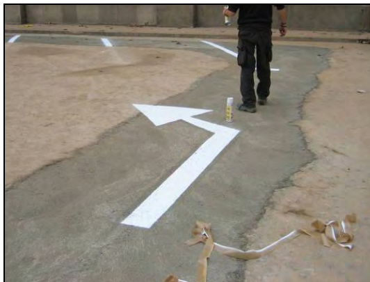
FOTO 35. Repintat de senyalització d'aparcament
