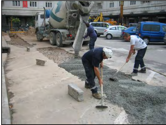
FOTO 25. Repavimentació del sector afectat pel sondeig A
