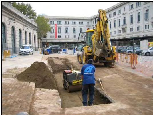
FOTO 11. Compactació del rebliment del sondeig A
