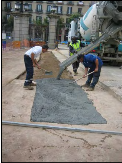
FOTO 13. Repavimentació de la zona afectada pel sondeig A
