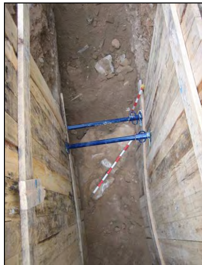
FOTO 24. Vista zenital de l'estructura UE 109
