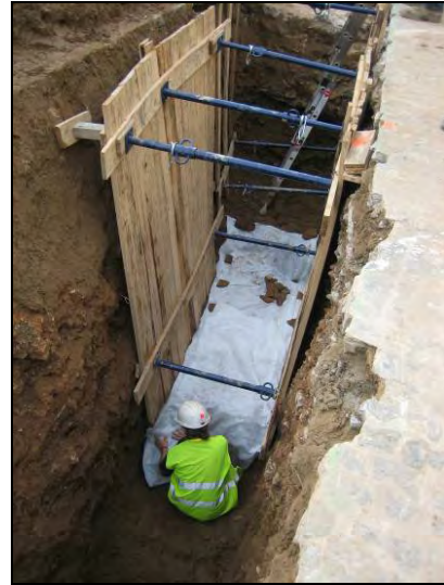
FOTO 10. Cobriment amb geotèxtil de l'estructura UE 106 abans de tornar a reblir el sondeig A
