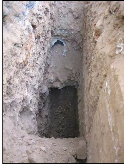
FOTO 22. Localització de l'estructura UE 109 al sondeig B2, a sobre podem veure el tub de formigó que s'hi recolzava
