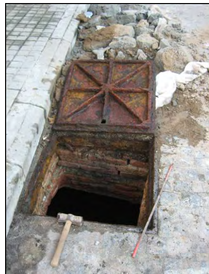
FOTO 16. Accés del dipòsit d'aigua localitzat durant la intervenció
