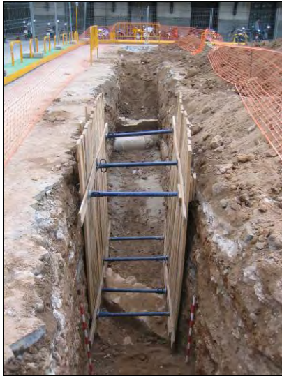
FOTO 29. Vista general del sondeig C. En primer terme podem veure l'estructura UE 111
