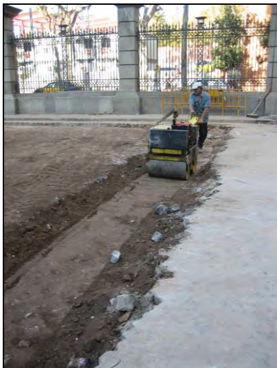
FOTO 31. Compactació del rebliment del sondeig C
